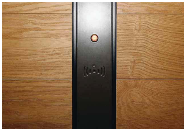
Versteckt eingebauter Wandler vor einer Gästezimmertür
